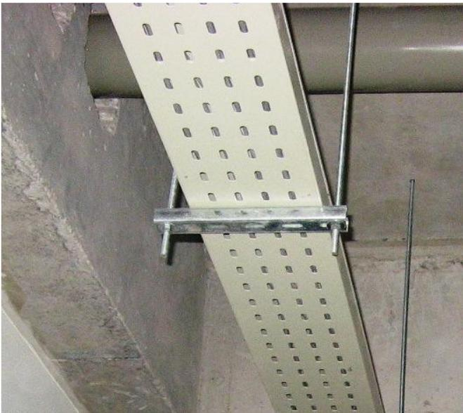
Este proyecto utilizará bandeja tipo ducto de dimensiones 30x12. La bandeja tipo ducto se instalará según los diseños en cada uno de los pisos del edificio, y deberá fijarse a la losa del edificio. Para el recorrido de las redes en el buitrón entre pisos se utilizará bandeja tipo malla cablefill.
