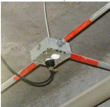
La tubería Conduit que se instale incrustada en placas, será tendida de forma tal, que su recorrido permita una fácil identificación posterior. La tubería a instalar a la vista será tendida en forma paralela o en ángulo recto con respecto a los muros y paredes del edificio.
